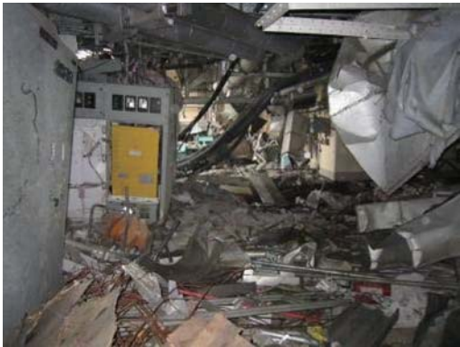
もっとも被害が軽かった4号機原子炉建屋3階の惨状。床が変形し、あたりは瓦礫が散乱している。現場は防護服を着用していれば入れる線量。しかし、事故後2年近くも経っているが、まだ本格的な作業環境にはない。なお3階は崩壊している床もある。
