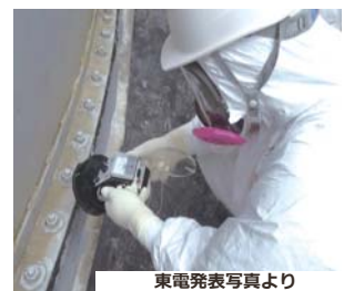
東電発表写真より タンクの継ぎ目計測時の写真
