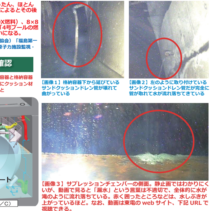
図2 1号機サブプレッションチェンバー内側の調査で漏水確認
