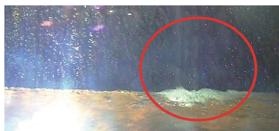
【画像3】サブプレッションチェンバーの側面。静止画ではわかりにくいですが、動画で見ると「漏水」という言葉は不適切で、全体的に水が滝のように流れ落ちている。赤く囲ったところなどは、水しぶきが上がっているほど。なお、動画は東電のwebサイト、下記URLで視聴できる。
