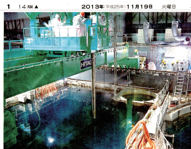
使用済み燃料プール内で、燃料集合体を燃料取り扱い機で搬送する容器に移そうとしている作業員ら ＝18日午後3時15分、福島第一原発4号機、東京電力提供
