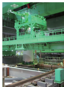
燃料取り出しのため、使用済み燃料プールに吊り下げられる搬送容器（中央下）＝18日正午すぎ、東京電力福島第一原発4号機（同社提供）
