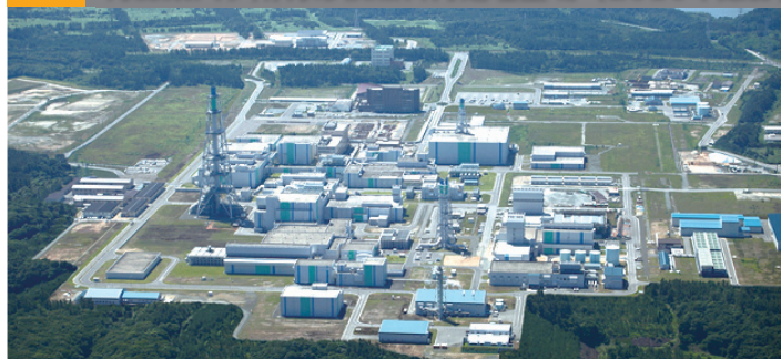
図 5 青森県六ヶ所村の核燃料再処理工場（2010年撮影）
