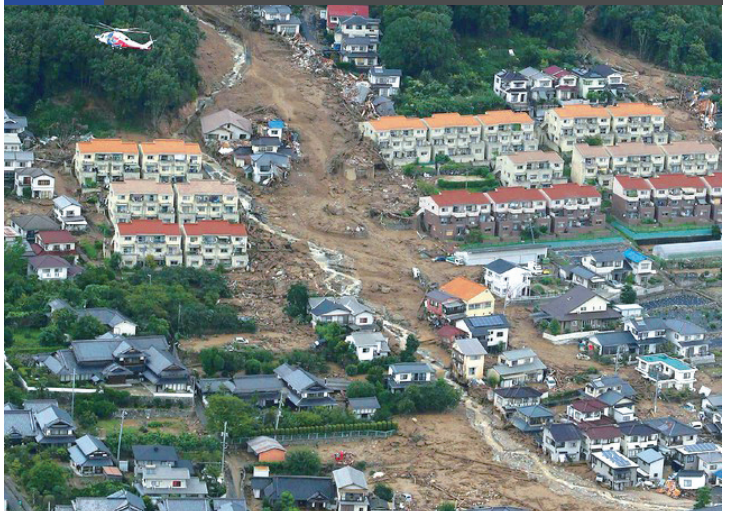
写真1 土石流で多くの死者を出した安佐南区八木地区
