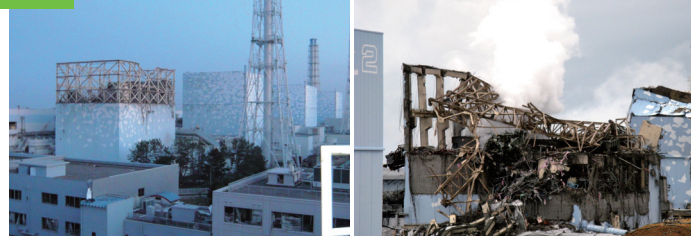
2011 年 3 月 12 日、水素爆発を起こした直後の 1 号機原子炉建屋外観
