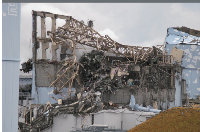
【写真引用】図 1・2、東京電力 web サイト「写真・動画集」より
