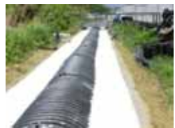
タンク設置エリア付近 排水路の暗渠化
