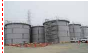
大型円筒型タンク
