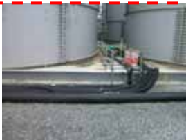
タンク廻りの堰の設置
