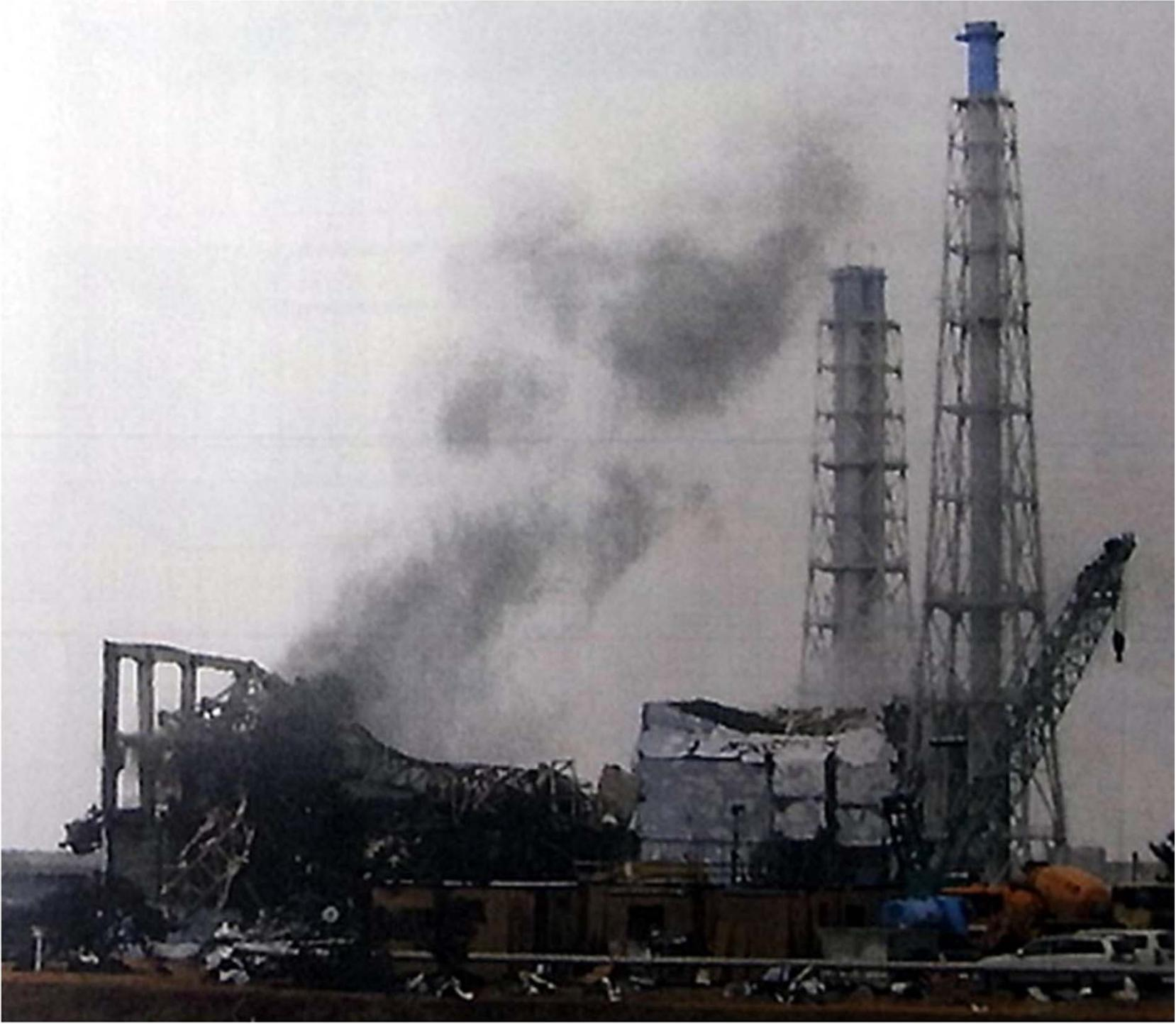
激しく壊れた3号機の原子炉建屋
